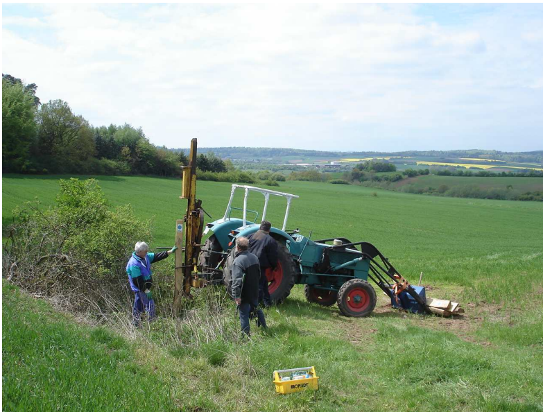
Einrammen der Markierungspfosten, im Hintergrund der Blick...
